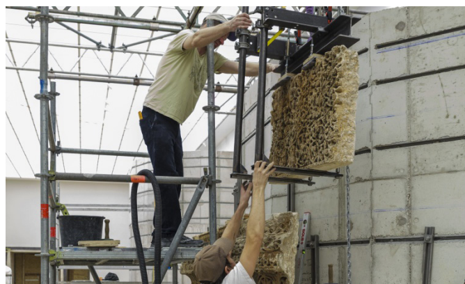
Abb.6: Wiederaufbau Mschatta-Fassade im Nordflügel, 2025
