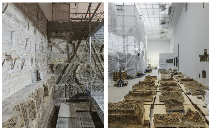
Abb.5: Abbau Mschatta-Fassadenteile im Südflügel
