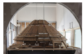
Abb.3: Alhambra-Kuppel - Demontage und Errichtung im Nordflügel
