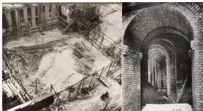
Abb.4: Baugrube Südflügel und Forum, Gründungsgewölbe
