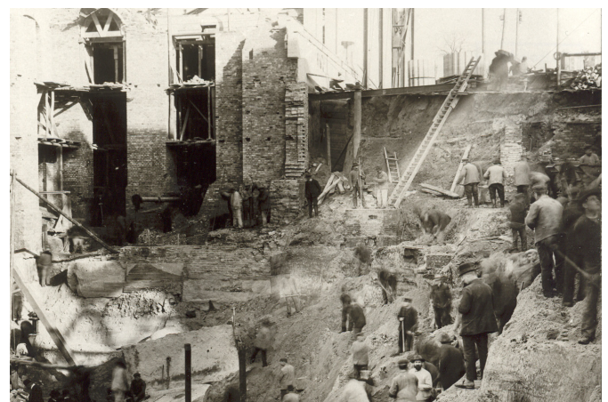
Abb.3: Nordflügel-Tiefkeller, händischer Aushub
