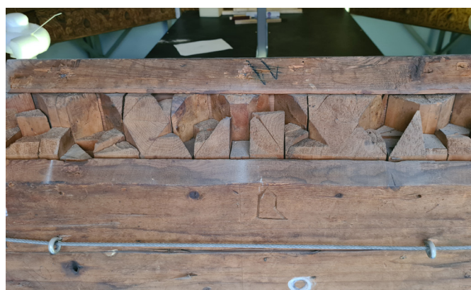
Abb.6: Zimmermannszeichen aus der Bauzeit der Kuppel
