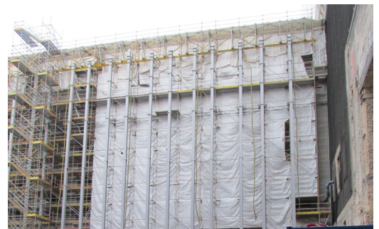
Abb.6: Wetterschutzdach NF, südliche Ansicht
