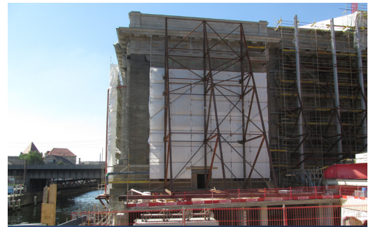
Abb.4: Wetterschutzdach NK, südl. Ansicht vom 4. Flügel
