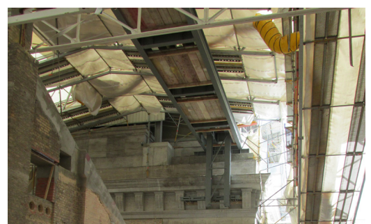
Abb.8: Wetterschutzdach MN, Auflagedetail Abfangung
