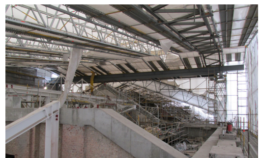
Abb.7: Wetterschutzdach MN, Innenansicht
