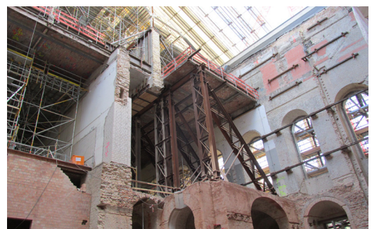
Abb.6: Baubehelf NF mit Rückbau Achse E
