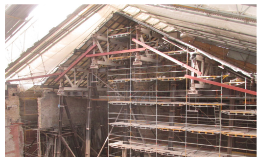
Abb.3: Baubehelf nach Rückbau Bestandswand E30, NK
