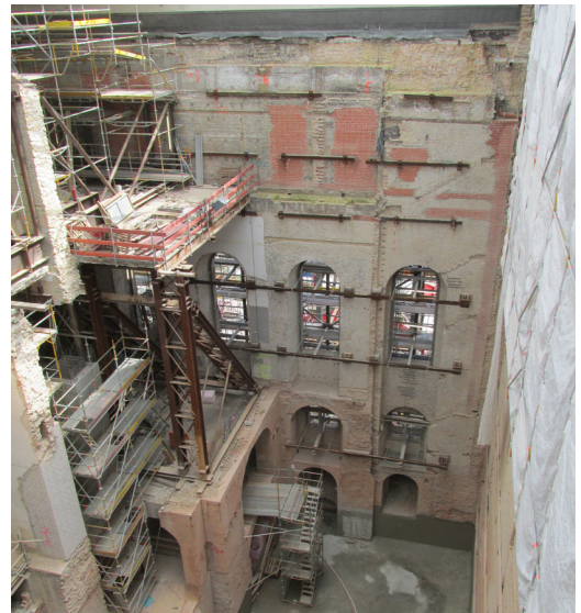
Abb.4: Baubehelf NF, Rückbau Kern U
