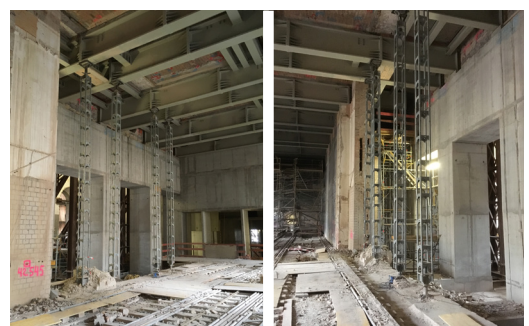
Abb.7: Baubehelf NF Rückbau Achse D und fertiggestellte Achse E
