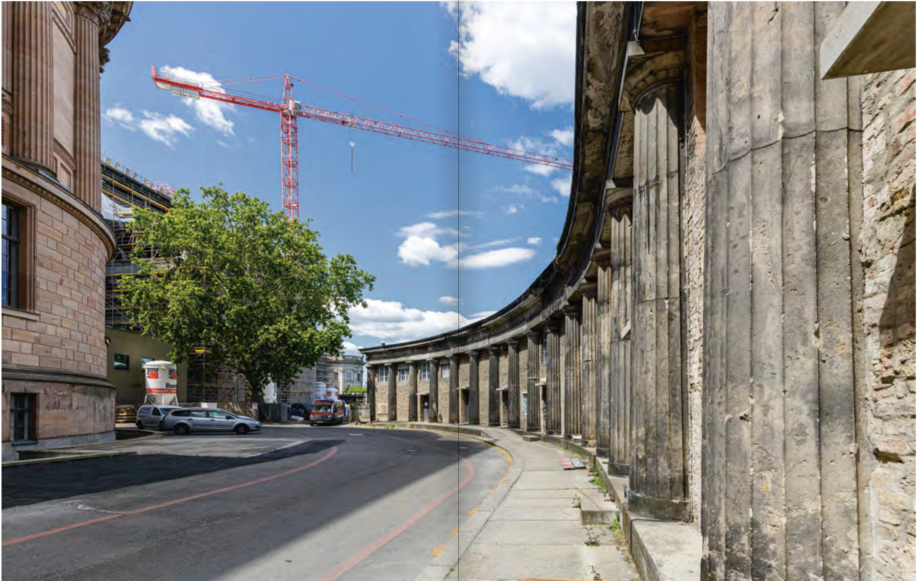
Nach der Wiederherstellung des Originalzustandes wird man zwischen den Kolonnaden wieder auf die Spree gucken können.
